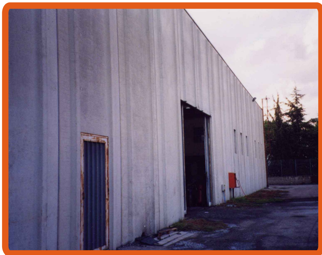
Foto n.13 - Prospetto Est con viale -
