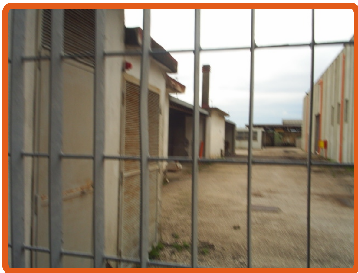
Foto n.8 - Prospetto Est con viale e pertinenze esterne -
