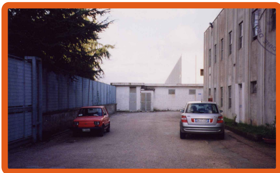
Foto n.10 - Prospetto Nord con viale -
