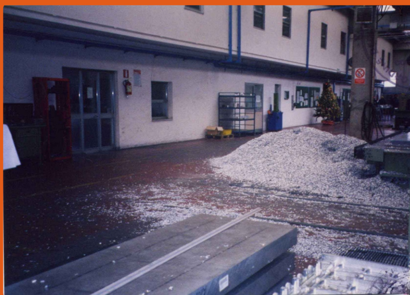
Foto n.16 - Area lavorazione lato uffici p.t. e 1° -
