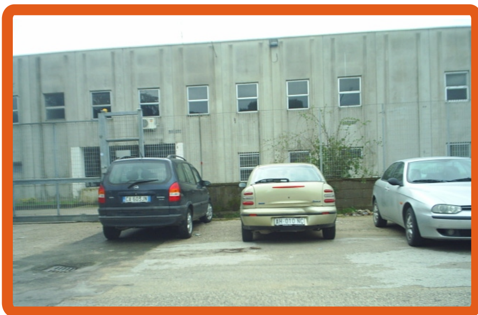
Foto n.9 - Ingresso (hall) lato Nord -
