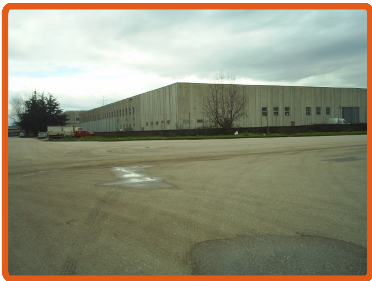
Foto n.5 - Prospetto Nord - Ovest -
