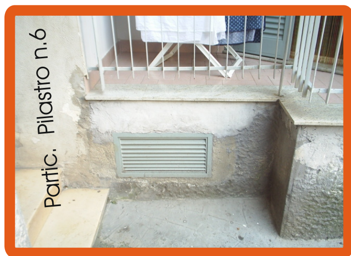
Particolari griglie di aereazione locale interrato
