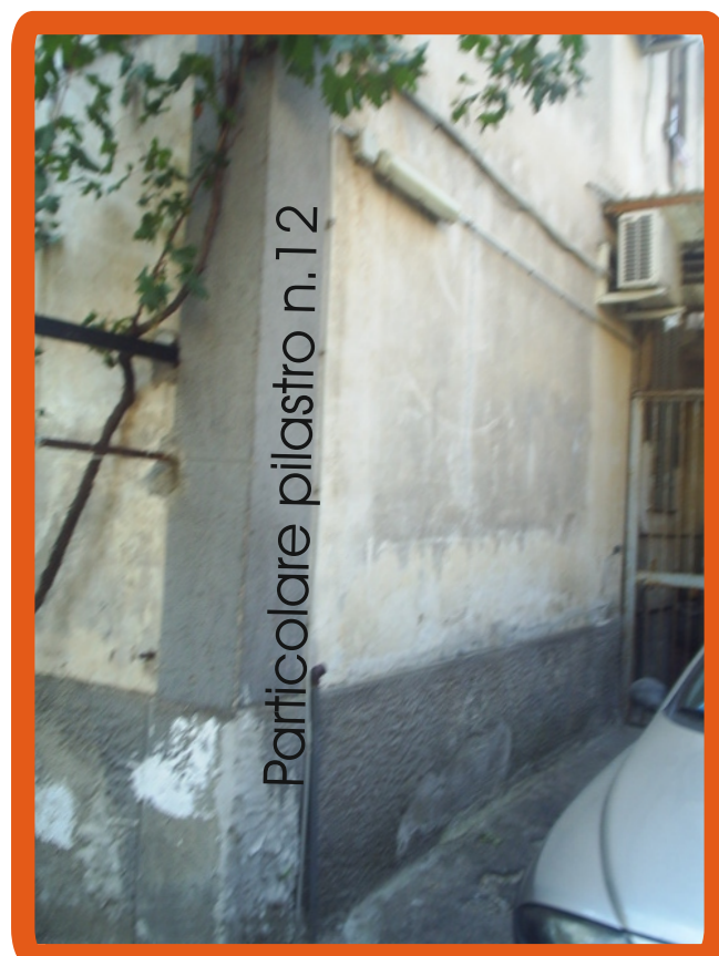
Particolare pilastro n.12
