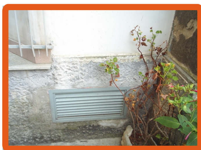
Particolari griglie di aereazione locale interrato
