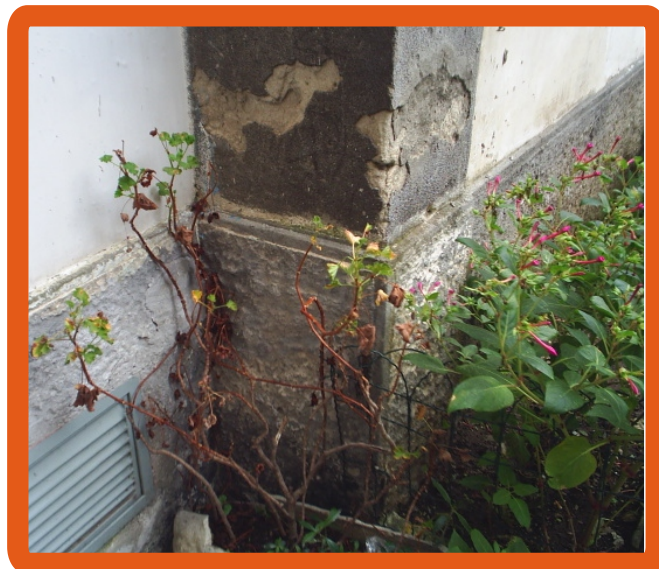
Particolare pilastro n.8
