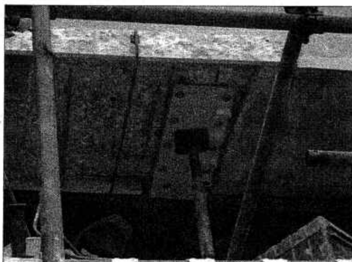
14 - Fissaggio della contropiastra.
