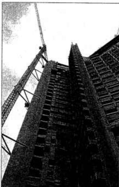
2. Il drastico intervento era assolutamente necessario, in quanto alcuni anni fa un incendio aveva reso inagibile la torre, provocando dissesti sulle strutture e danni diffusi sulle facciate (visibili nella foto).
