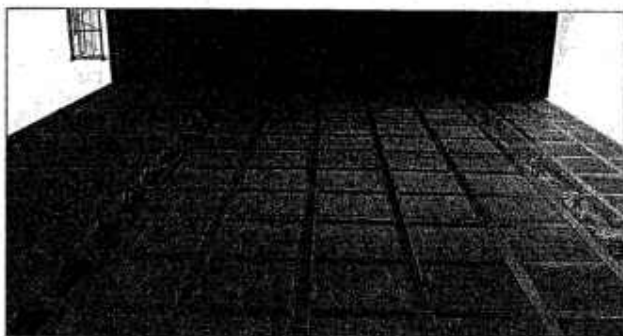
14. Le dimensioni dell'intervento sono decisamente imponenti: in cantiere sono stati utilizzati oltre 20.000 metri lineari di lamine, 5.000 metri quadrati di tessuti e circa 25 tonnellate di resine sintetiche. Visti i numeri, il cantiere di Napoli si presenta come uno dei più interessanti al mondo per verificare la qualità e l'efficacia dei metodi e delle tecnologie di rinforzo con compositi in fibre di carbonio.
