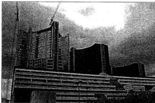
1. Il consolidamento strutturale con compositi fibrosi della Nuova Torre A del Palazzo di Giustizia di Napoli è, per tipologia di intervento, il più grande cantiere attivo in Europa.
