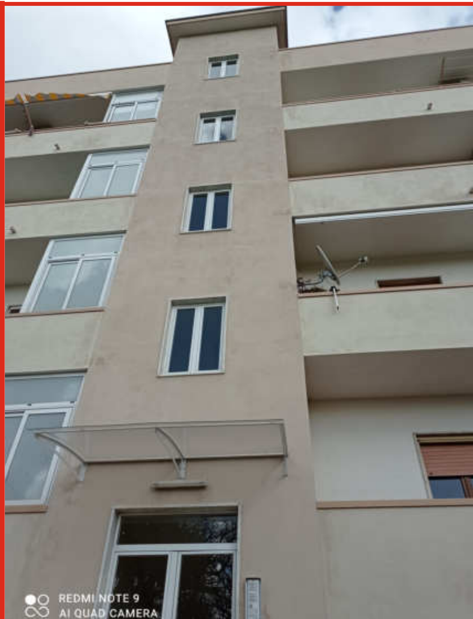
Foto n.3 - Vista facciata esposta ad ovest - particolare scala condominiale
