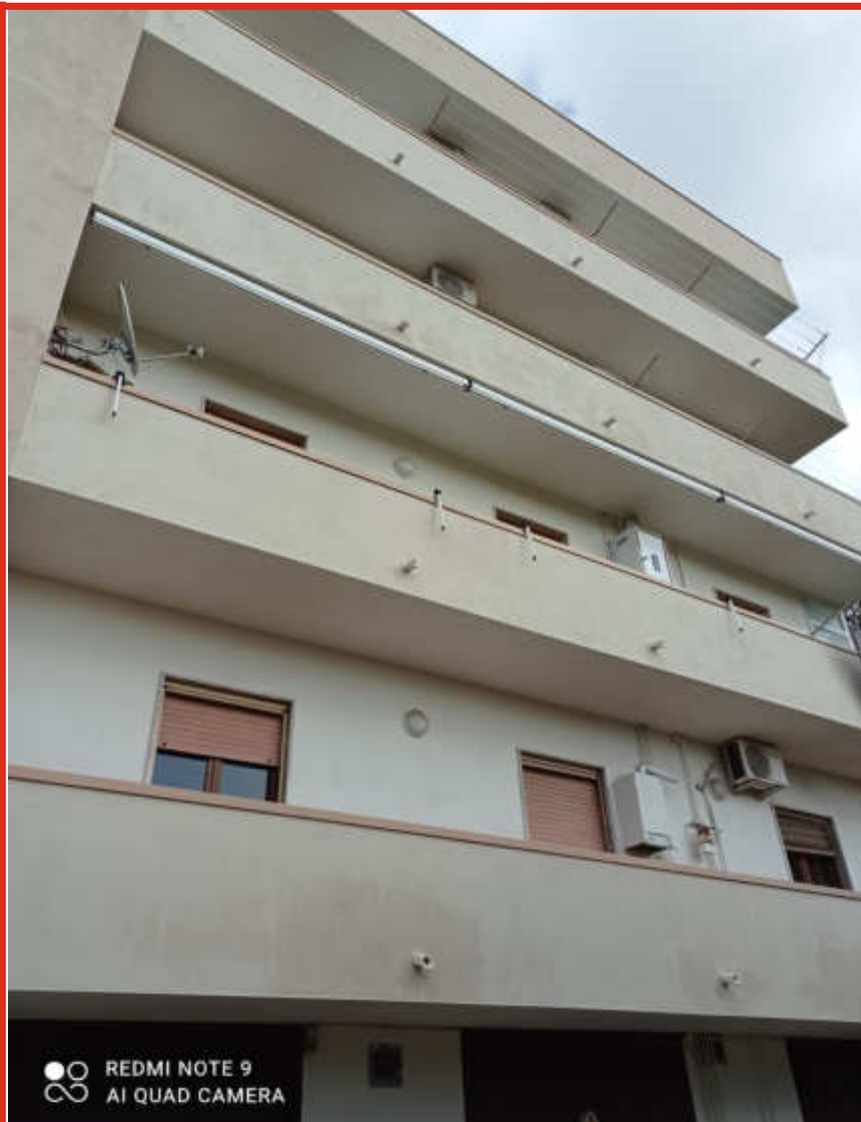
Foto n.1 - Vista facciata esposta ad ovest -
