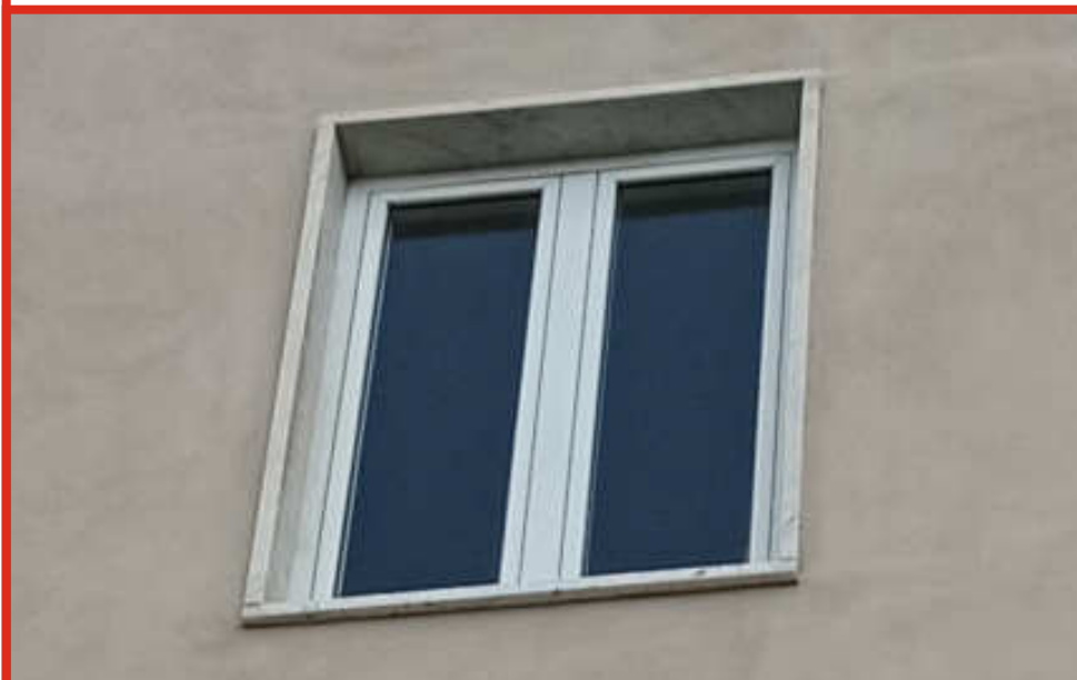
Foto n.4 - Vista particolare finestra scala condominiale
