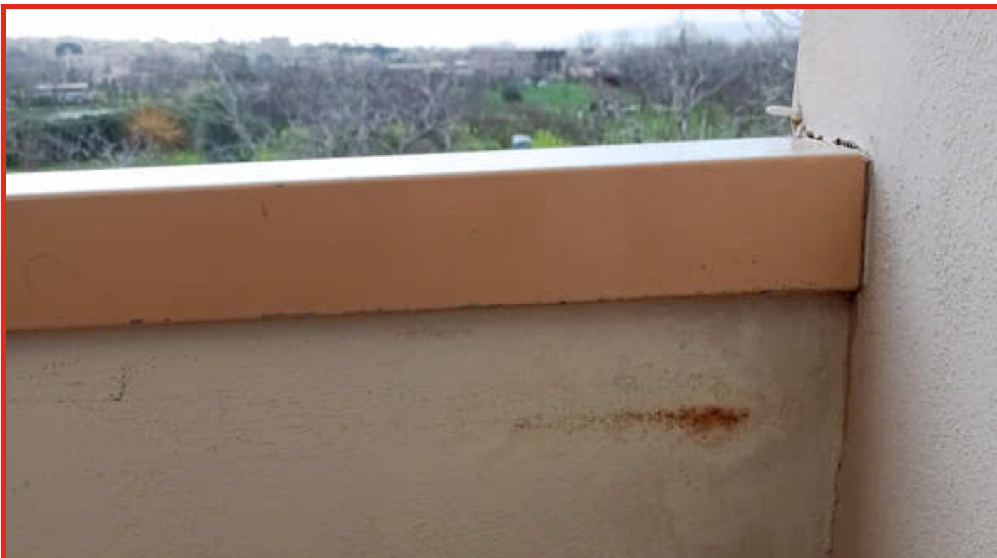
Foto n.11 Vista dettaglio formazione macchia di ruggine , sul parapetto del balcone prop. int. n.9
