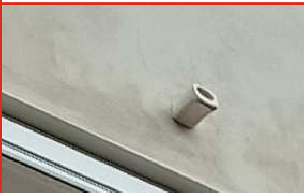
Foto n.2 - Vista particolare gocciolatoio
