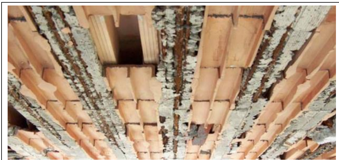
Foto solaio dopo evento del fenomeno dello sfondellamento
